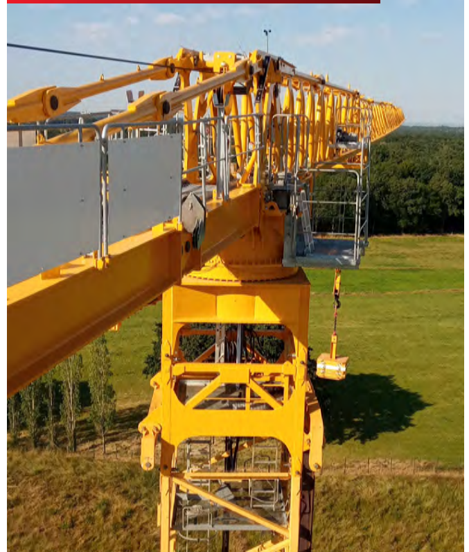
Mastschuss K84/K84-2 direkt unter dem Krankkopf verbolzt
