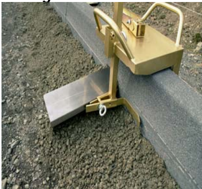
Das Rinnenfix RF-H wird entsprechend den Vorgaben in der Höhe und in der Breite eingestellt
