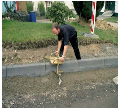
Das Gerät wird vom Bediener geschoben, wobei es sich oben und hinten über Rollen am Bordstein abstützt und so die Höhe exakt auf das Planierschild überträgt
