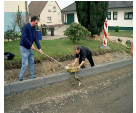
Bei großem Materialanfall bzw. großer Arbeitsbreite kann über eine integrierte Schaufel-Einhängevorrichtung ein zweiter Bediener mithelfen
